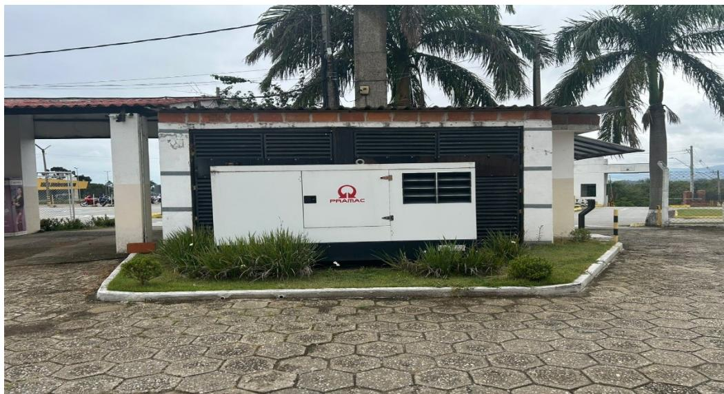
Além do sistema solar, o UNIFUNVIC conta com um gerador de energia de alta capacidade como item de redundância. Este gerador entra em operação automaticamente em situações críticas, quando há uma interrupção prolongada no fornecimento de energia ou durante a manutenção do sistema solar.
